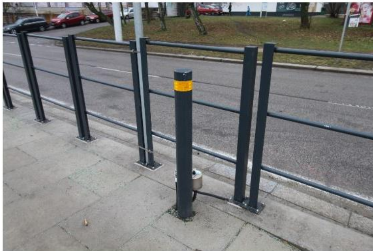
Obrázok 99_Príklad majáčka a nežiadúce riešenie ukoľajnenia
