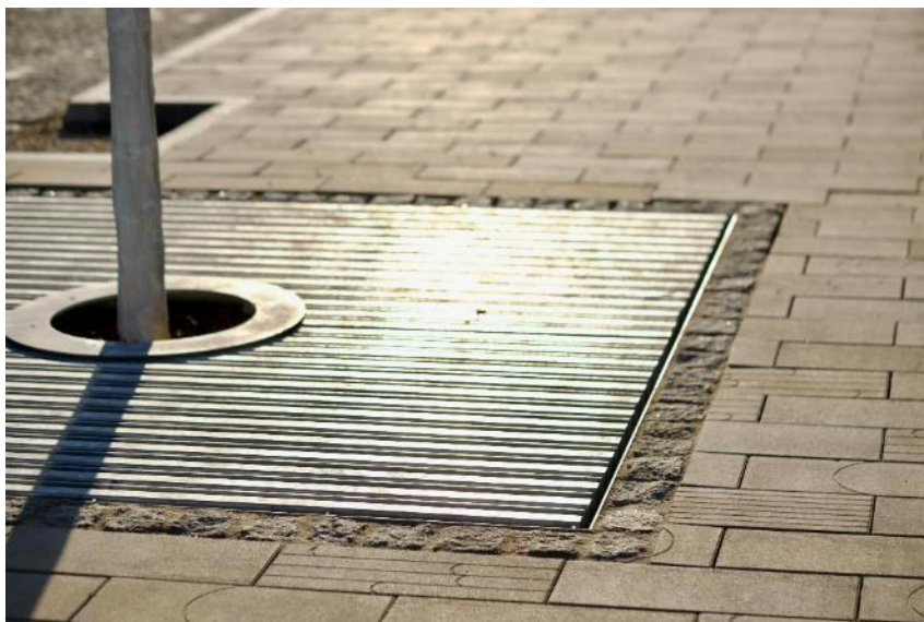
Obrázok 179_Olemovanie stromovej mreže strednou štiepanou dlažobnou kockou – príklad z Mýtnej ulice
