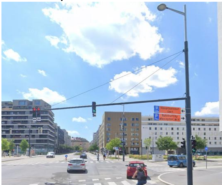
Obrázok 143 Príklad integrácie CDS so stožiarom verejného osvetlenia. Viedeň
