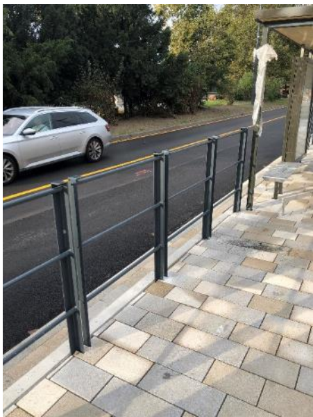
Obrázok 70_Příklad kotvení zábradlí pod povrchem dlažby
